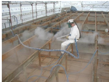
Tagkonstruktion afrenses med isafrensning. Efterfølgende støvsuges tagkonstruktionen samt behandles forebyggende med ProtoxSkimmel.
