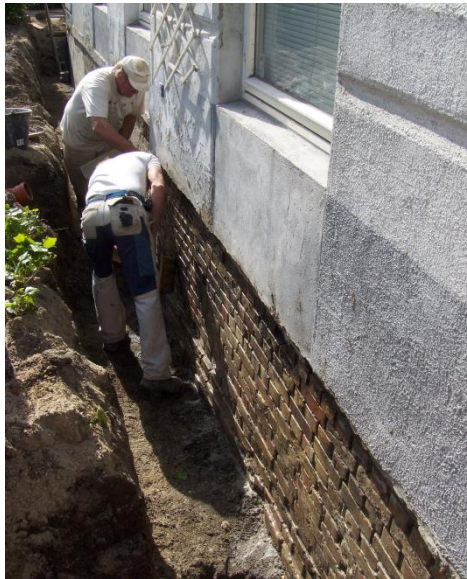
Udførsel af dræn og fugtisolerings af kælderydervægge
