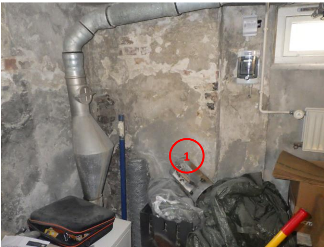
Fig. 5 Udsnit af kælder
