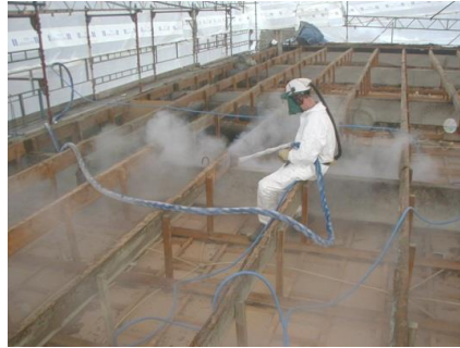
Tagkonstruktion afrensnes med isafrensning. Efterfølgende støvsuges tagkonstruktionen samt behandles forebyggende med ProtoxSkimmel.
