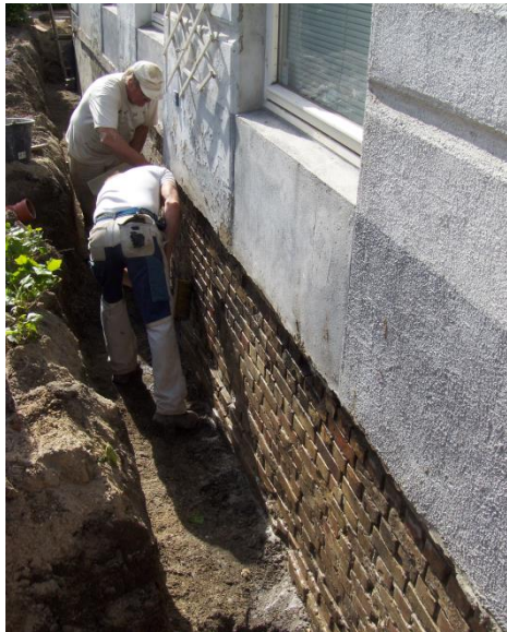
Udførsel af dræn og fugtisolerung af kælderydervægge
