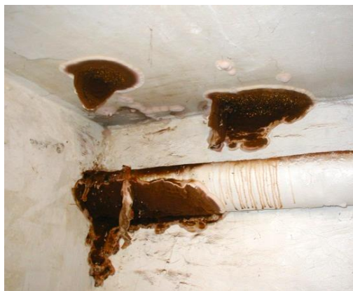
Angreb af Ægte hussvamp ( Serpula lacrymans ) i kælderdek (kælderloft), som følge af opstigende grundfugt. Bjælkelaget over pudsen var meget nedbrudt.
