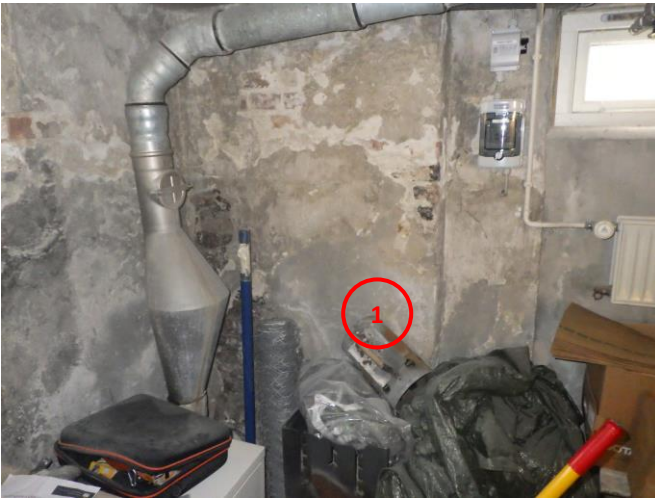
Fig. 5 Udsnit af kælder
