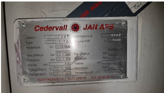
Foto 18: 1000 liter VVB fra 1997 i varme-central.
